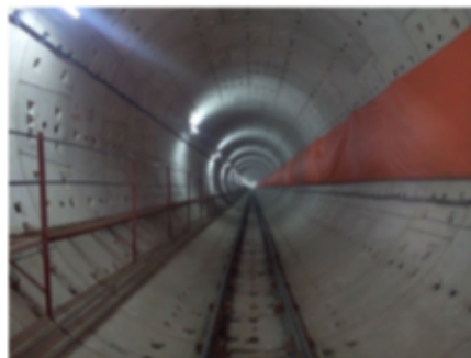
盾构隧道内管线布设示意图
